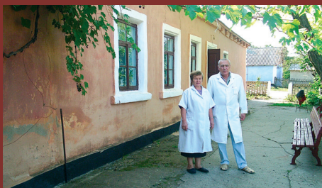
Дільнична лікарня, збудована на поч. XX ст.
